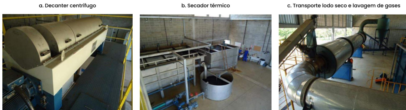
Figura 23 – Sistema de desaguamento e secagem térmica do lodo ETE Araraquara
