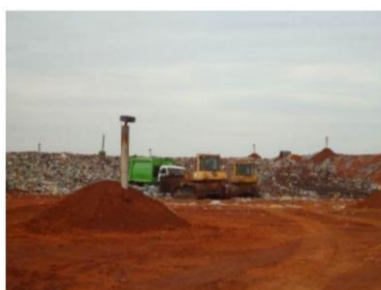
b. Compactação dos resíduos em camadas
