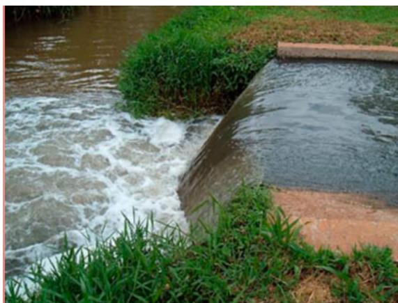
Figura 13 – Lançamento no corpo receptor realizado pela ETE Araraquara
