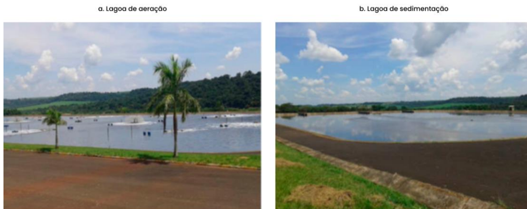
Figura 15 – Sistema de tratamento secundário ETE Araraquara: a) lagoa de aeração, b) lagoa de sedimentação.
